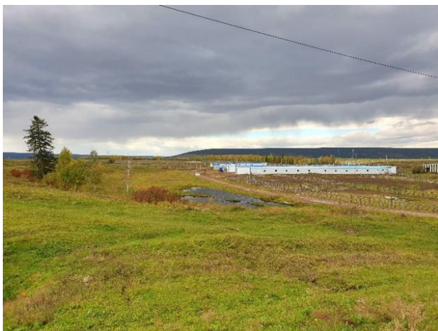
Рис. 42. Здание фермы ООО «Кладовая Олекмы», построенное на участке со слабльдистыми многолетнемерзлыми породами, с. Юнкюр, сентябрь 2022 г. Фото А.А. Сулейманова.
