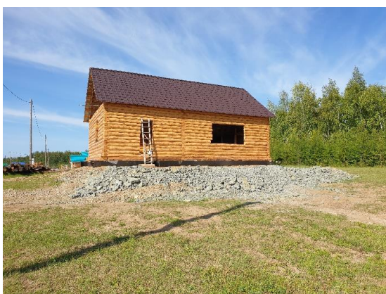
Рис. 40. Адаптация технологии строительства к условиям деградации ММП: сооружение дома на отсыпке из коренных пород и металлической раме в качестве фундамента, с. Улахан-Ан, август 2022 г. Фото А.А. Сулейманова.
