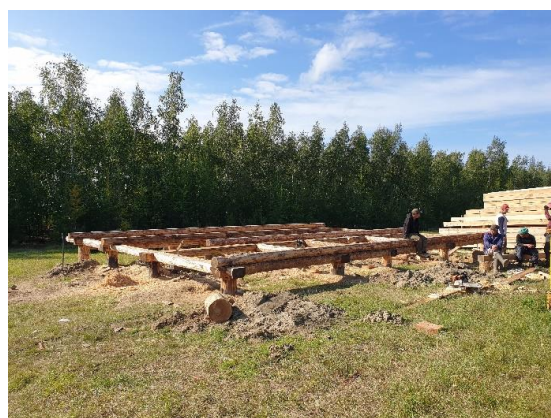
Рис. 41. Адаптация технологии строительства к условиям деградации ММП: сооружение основания дома на 5-ти метровых лиственничных сваях, с. Улахан-Ан, август 2022 г. Фото А.А. Сулейманова.
