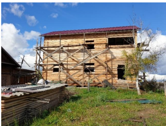
Рис. 38. Адаптация технологии строительства к условиям деградации ММП: сооружение дома на старых автомобильных покрышках с соблюдением принципа вентилируемого подполья, с. Юнкюр, сентябрь 2022 г. Фото А.А. Сулейманова.
