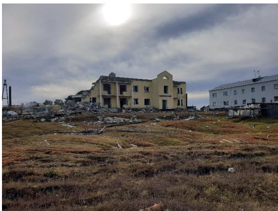
Рис. 44. Остатки построенного без свайного фундамента «Экспериментального дома», с. Амга, сентябрь 2021 г. Фото А.А. Сулейманова.
