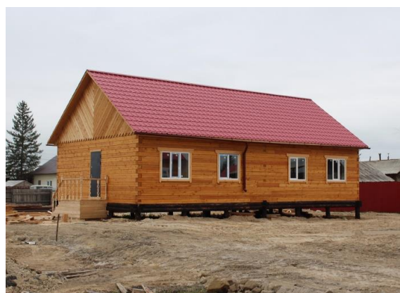
Рис. 39. Адаптация технологии строительства к условиям деградации ММП: сооружение дома на свайном фундаменте, с. Амга, сентябрь 2022 г. Фото С.А. Григорьева.
