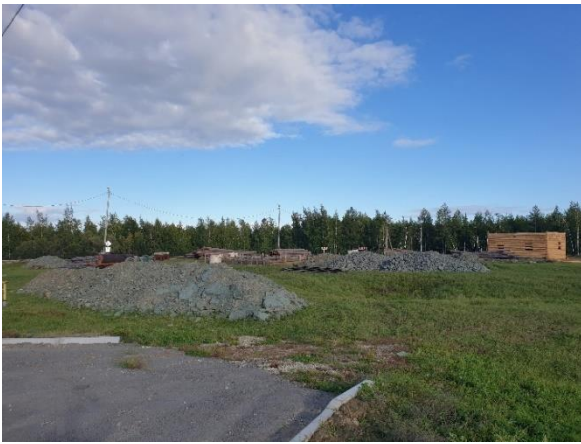
Рис. 23. Строительство в зоне активизации термокарстовых процессов, микрорайон «Чэчир», с. Улахан-Ан, август 2022 г. Фото А.А. Сулейманова.
