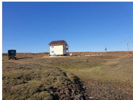
Рис. 21. Строительство домов в микрорайоне «Нелегер» на участках с глубоко расчленёнными быларами, с. Амга, сентябрь 2021 г. Фото А.А. Сулейманова.
