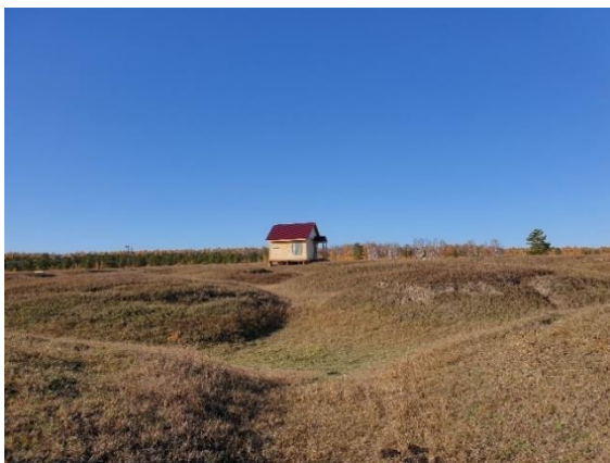
Рис. 20. Строительство домов в микрорайоне «Нелегер» на участках с глубоко расчленёнными быларами, с. Амга, сентябрь 2021 г. Фото А.А. Сулейманова.
