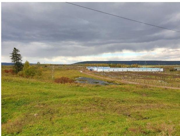
Рис. 42. Здание фермы ООО «Кладовая Олекмы», построенное на участке со слабльдистыми многолетнемерзлыми породами, с. Юнкюр, сентябрь 2022 г. Фото А.А. Сулейманова.
